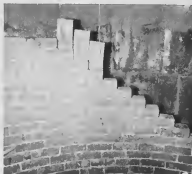
Brick lining and outer wall. Un muraya di klinker, un di concret.
